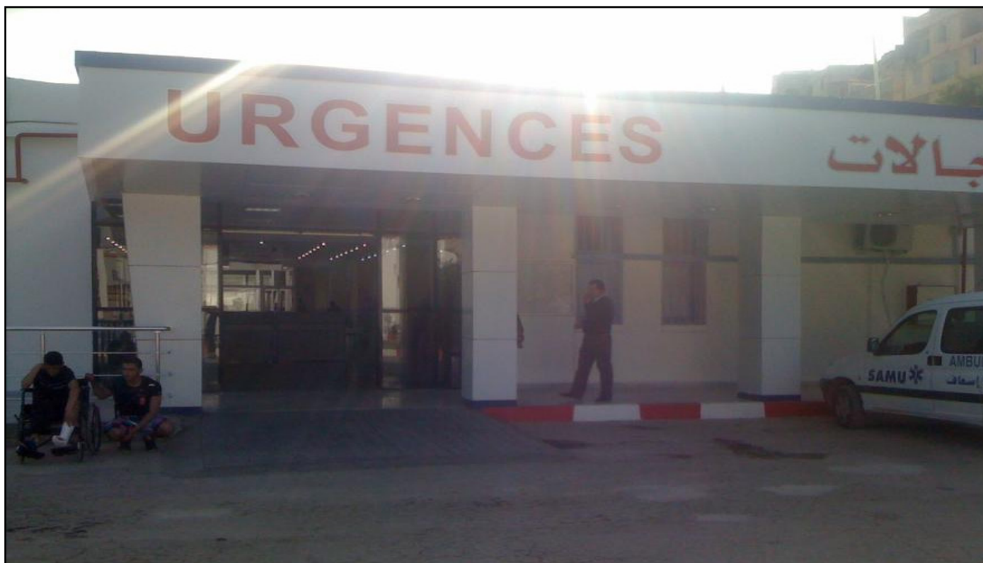
Figure 1 : Vue de l'extérieur du service des UMC-CHUB
