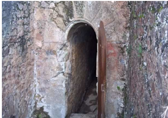
Figure N°35 : entrée du tunnel
