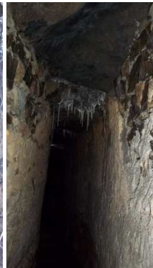
Figure N°36 : intérieur du tunnel
