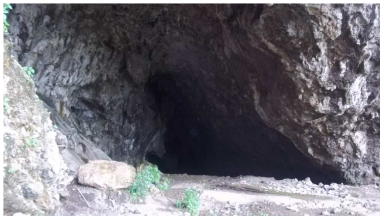
Figure N°24 : Entrée de tunnel d'Aokas
