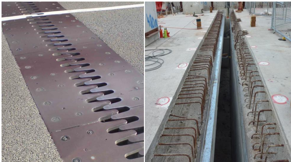
Figure 2: Rainures de dilatation sur un pont. [2]
