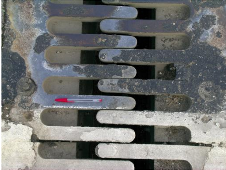
Figure 3: Partie d'un joint de dilatation entre deux portions d'une route. [4]
