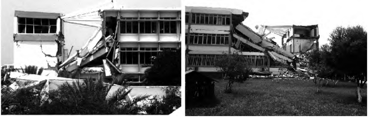
Figure II.16 : Effondrement partiel d'un bâtiment faute de mauvaise conception (séisme Boumerdes2003) [48].
