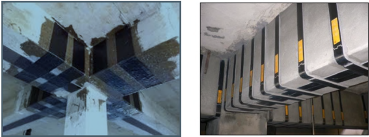
Figure II.25 : Renforcement des poutres par des matériaux composites [63].
