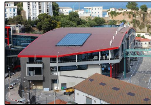
Figure 126: façade d'équipement de transport " gare maritime"
