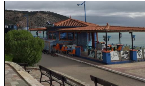
Figure 122: façade d'un équipement commercial « cafétéria »
