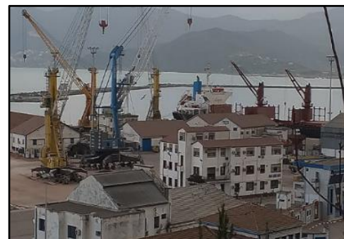
Figure 120: façade d'un équipement de service portuaire
