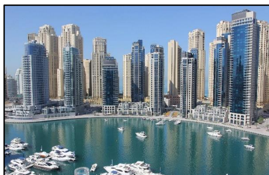
Figure 27: Les bâtiments du Dubaï waterfront
