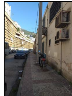
Figure 179: photo sur la voie du 2 ordre
