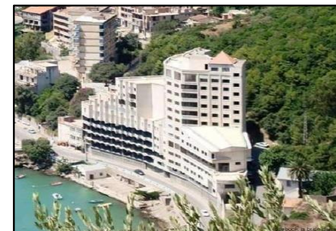
Figure 119: façade d'un équipement de service " hôtel de la brise"
