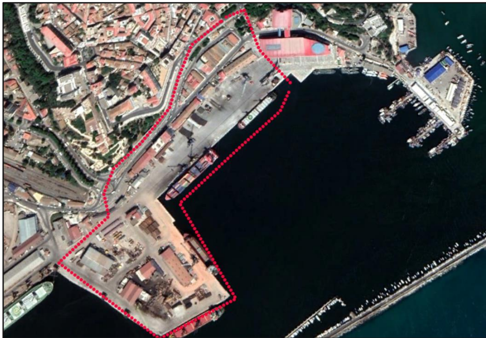
Figure 1: la zone d'intervention du vieux port de Béjaïa
