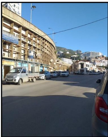
Figure 154: photo du bâtiment rampe
