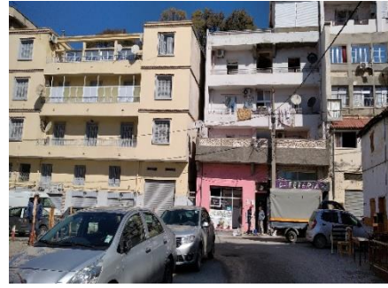
Figure 134 : Les bâtiments donnant sur la rue d'Ibn Khaldoun
