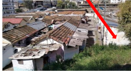
Figure 109 : Vue 02 sur La cité des Eucalyptus (Source : Auteur 2021)
