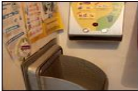
Figure 14 : La commande et le dispositif de système de puit d'ordure sélectif (Source : recyclage-recuperation.fr)
