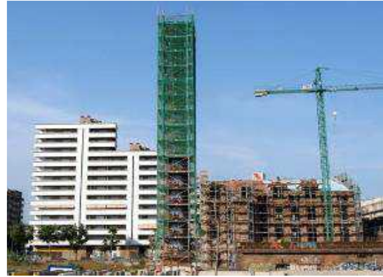
Figure 8: Protection du patrimoine au quartier 22@ Barcelone
