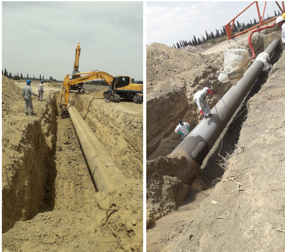
FIGURE 4.1 – Photos des travaux de ré-enrobage « Excavation, Enrobage »
