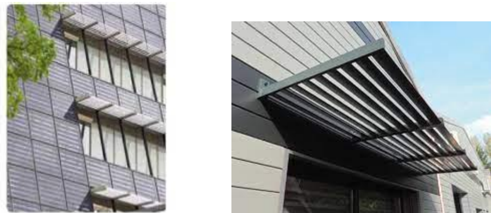
Figure I.26 : Les types de protections solaires horizontales
