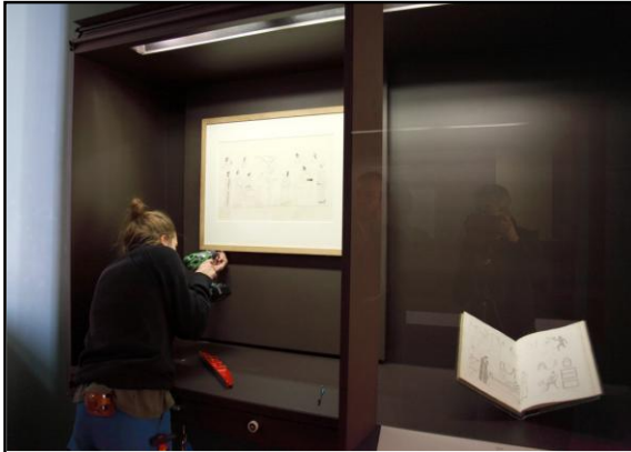
Fig. 17 ; Vissage des pattes de fixation, Musée du Louvre / A. Mongodin.
