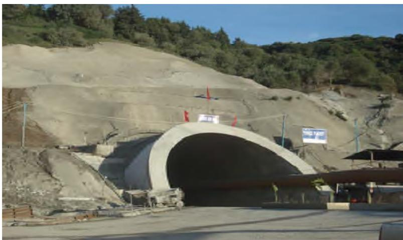
**Figure.III.12.** Faux tunnel au niveau de la tête nord.
