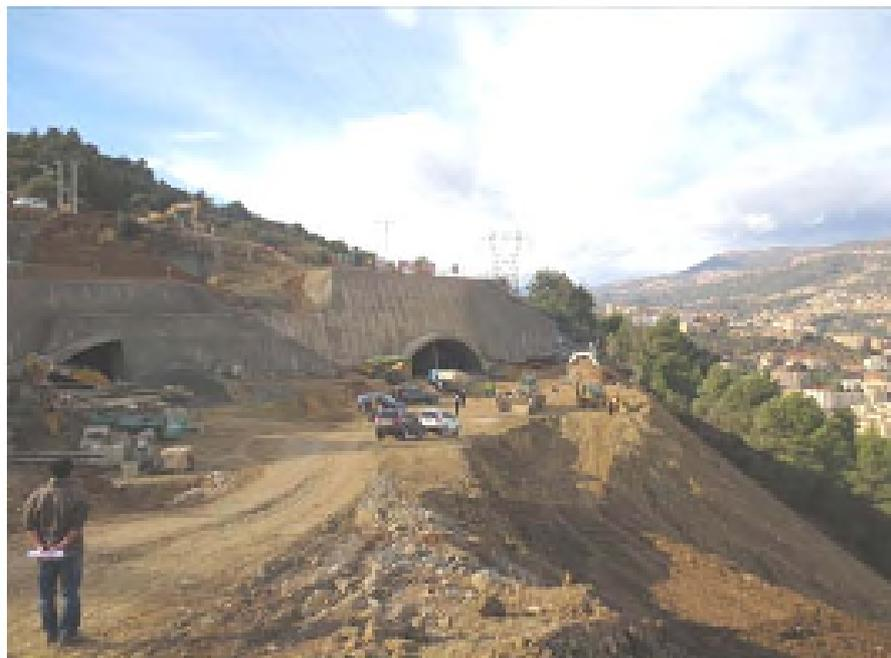
**Figure. D.** Après creusement de la tête nord du tunnel.
