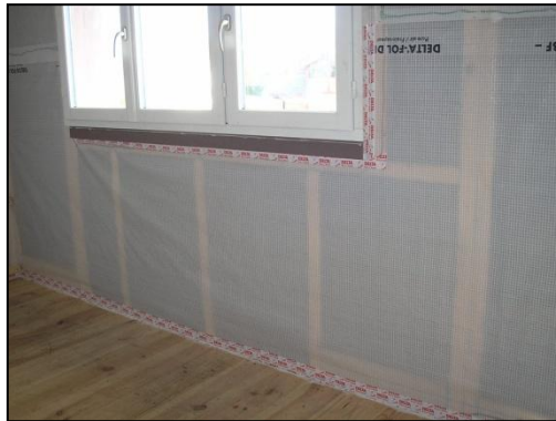
Figure60: pare vapeur entre les fenêtres et les murs .Source: www.bati-journal.com (15/02/2015.21:37).
