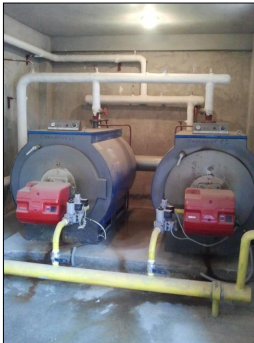
Figure50:La chaudière installé dans l'immeuble(chaudière classique a gaz naturel).
