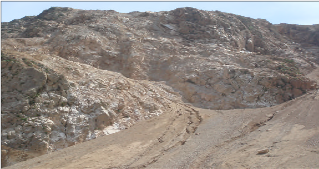
Photo I.10. Travaux de décapage de la terre végétale et de la partie stérile du gisement de la carrière de Djebel Merada.
