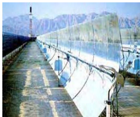
Figure II. 27: Concentrateur linéaire. Puissance qui peut atteindre de 20 à 50 kWh
