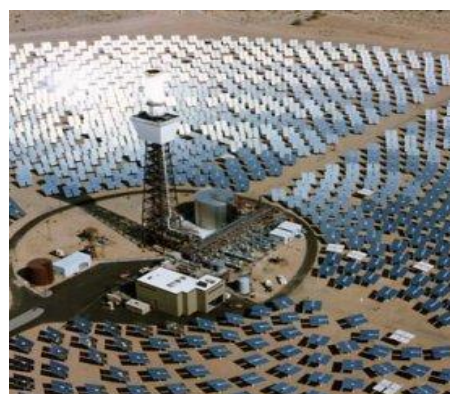
Figure II. 25 Centrales électriques thermiques Solaires (miroirs plans) Température qui peut atteindre 3800°C puissance 1000kW (Pyrénées-Orientales)
