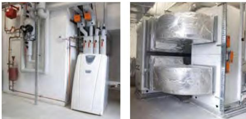
Figure IV. 10: Pompe à chaleur et centrale de traitement d'air Source : www.charon-rampillon.com
