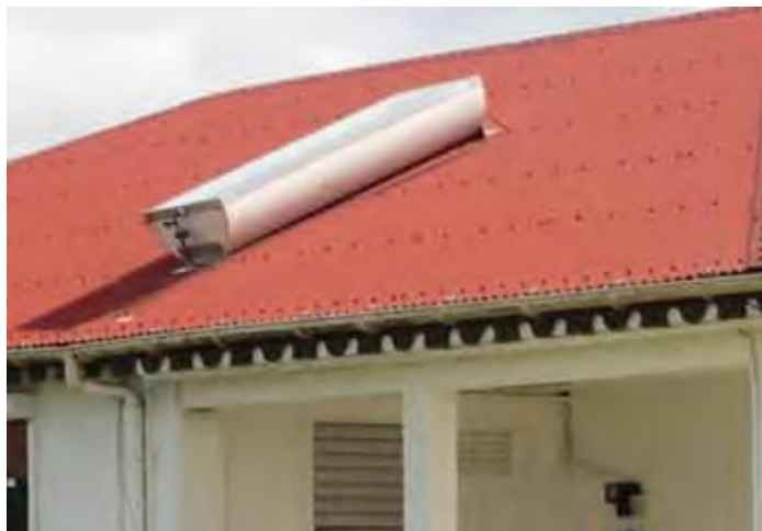
Figure II. 22: Principe de fonctionnement du chauffe-eau solaire auto stockeur Source : CNRS Héli odyssée
