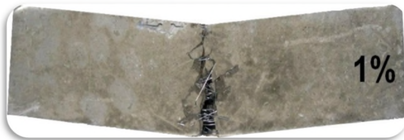
Figure II.3 : Fissuration en Béton avec fibres
