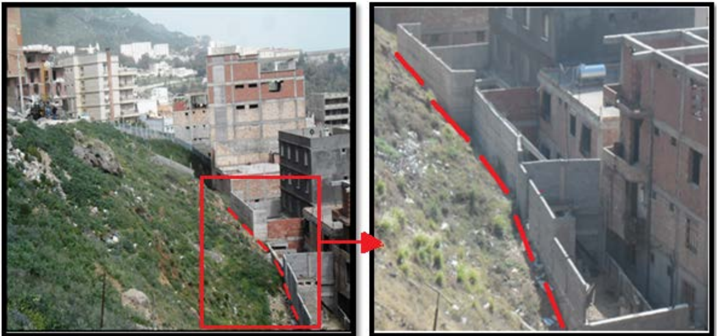
Figure II-13: Elimination de la butée (Terrassements)
