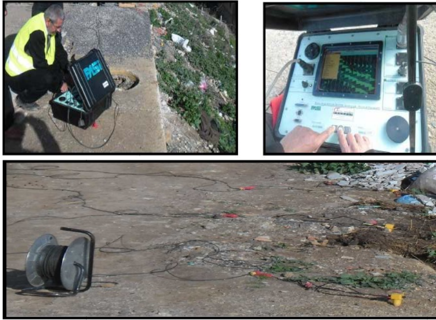
Figure II-19 : Equipement de mise en œuvre de l'essai sismique réfraction.
