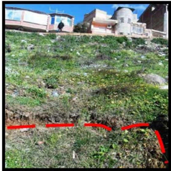
Figure II-11: Fissure côté Est
