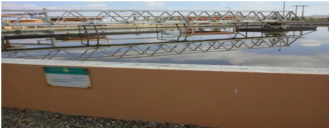
Figure 7. Le décanteur primaire [11]
