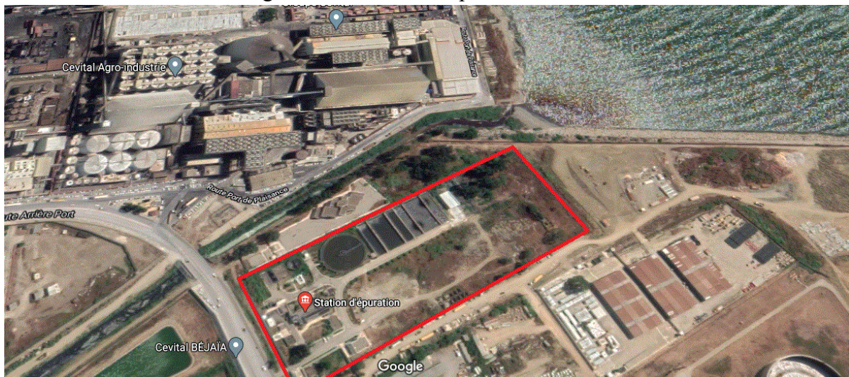
Figure II.2 : Géolocalisation de la STEP de Béjaïa (Google maps le 14/09/2020)
