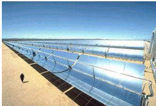
Figure II.6 : Système à réflecteur cylindro-parabolique [16].
