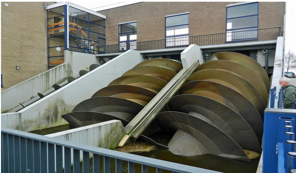
Figure II.9 Machine élévatoires simple à vis d'Archimède. [6]
