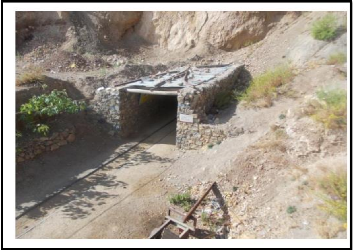
Figure IV.3: photo de la galerie d'Ouverture du niveau 1110 m, gisement Nord
