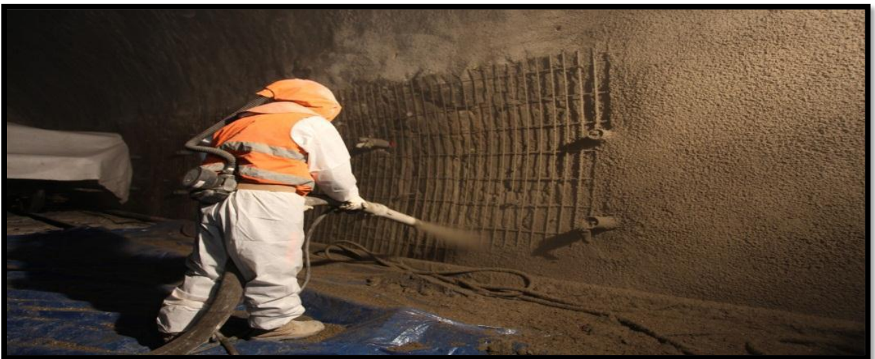
Figure II.13: Mise en œuvre du béton projeté.
