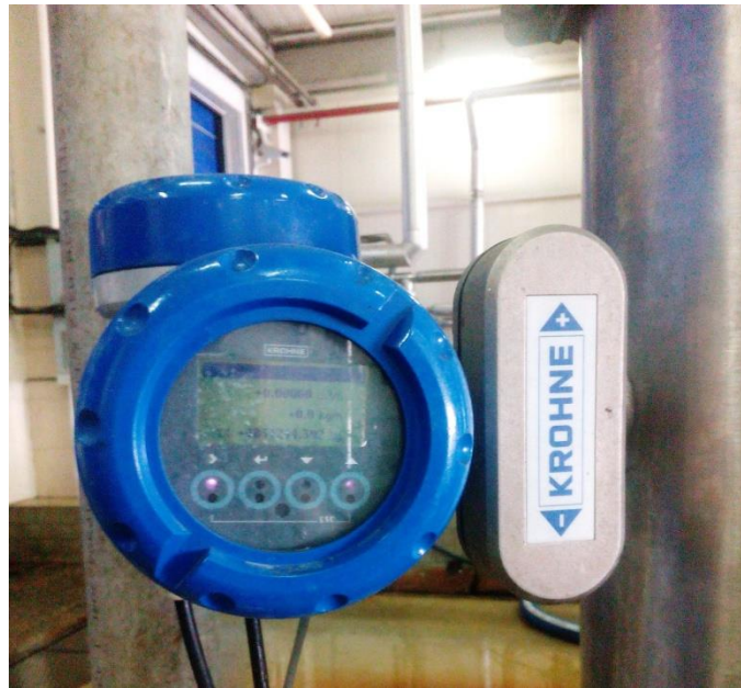
Figure I.6.8 Débitmètre KROHNE
