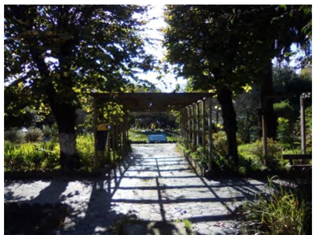
Figure 53:Passage couvert dégradé dans le square Pasteur source auteur 2021
