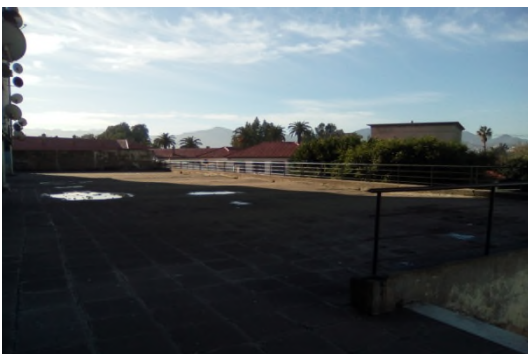
Figure 27: Terrasse du marché couvert "Lebkhas" Source : auteur, 2021
