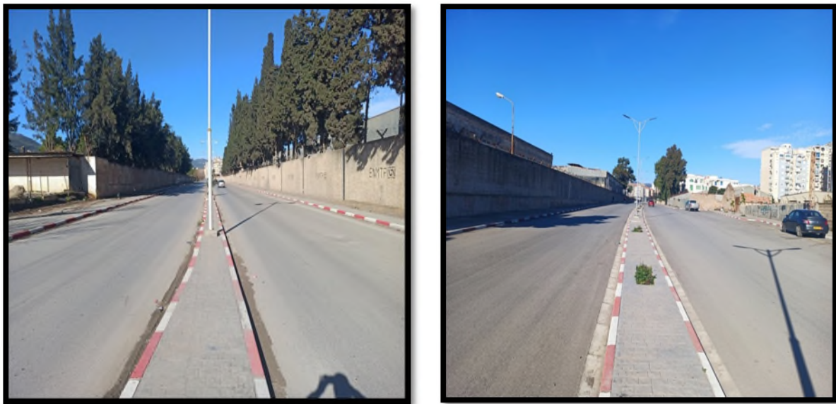
Figure 97: voies secondaires de type 1 (auteurs le 12/02/2021)
