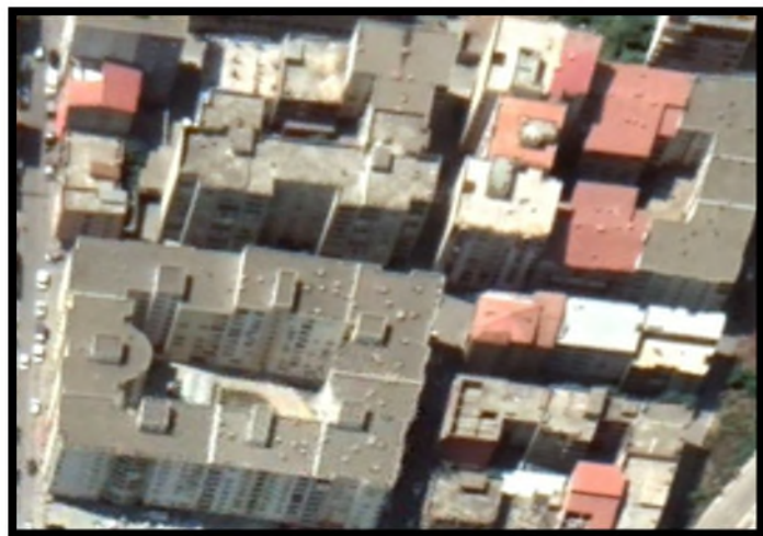
Figure 125: vues aériennes des variétés architecturales (google earth)
