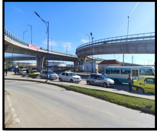
Figure 103: échangeur des 04 chemins (auteurs le 12/02/2021)
