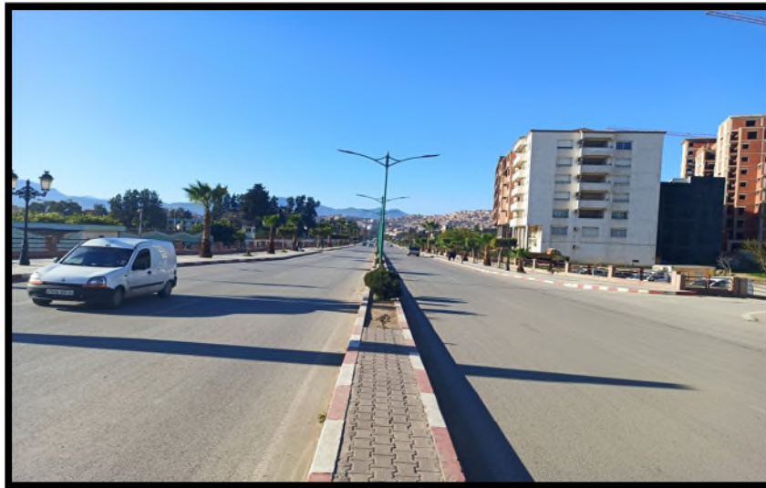
Figure 95: boulevard des Aurès (auteurs le 12/02/2021)
