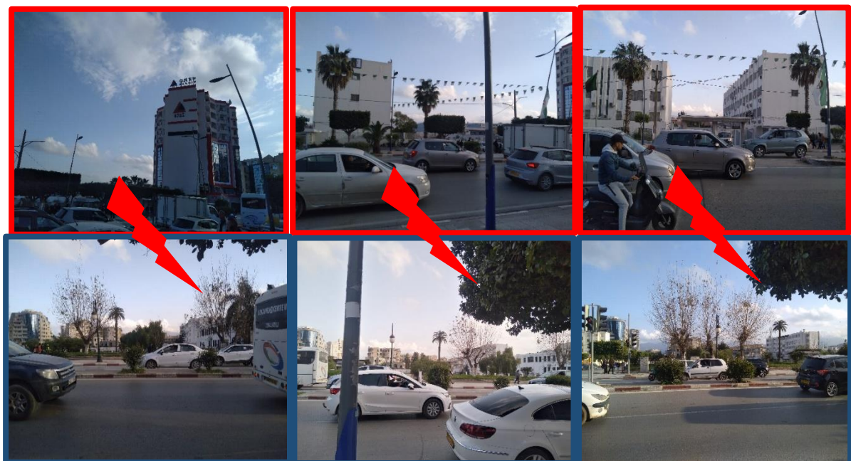
Figure 125 : La façade des constructions avoisinantes du site.
