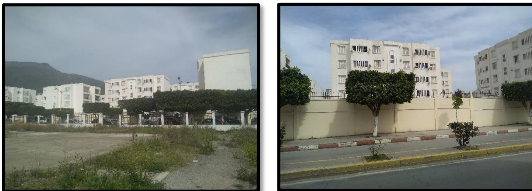
Figure 139 : Le site avant l'intervention
