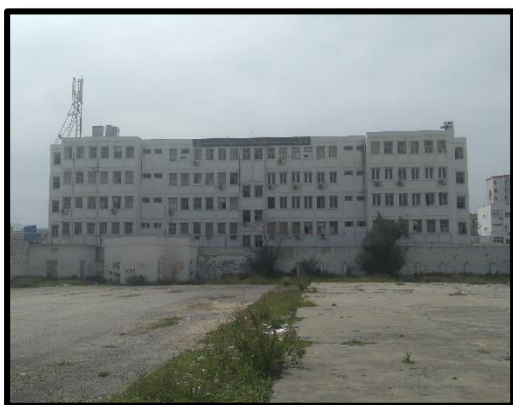
Figure 142 : Bloc de siège de la wilaya avant l'intervention.
