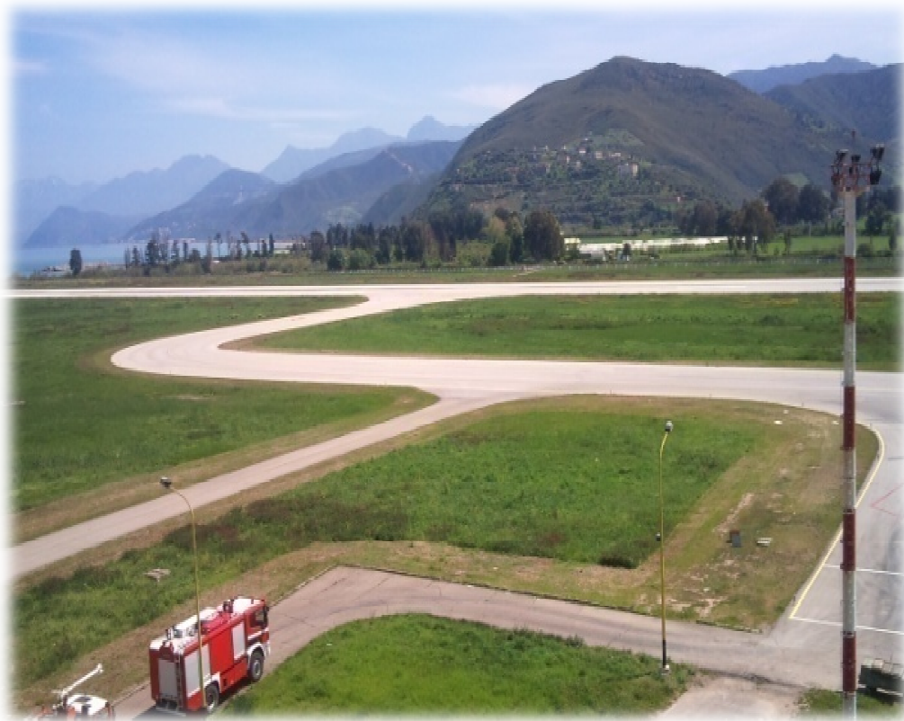
Figures a et b : Vue aérienne de l'aéroport de Bejaia (a), Vue sur les pistes de l'aéroport de Bejaia
