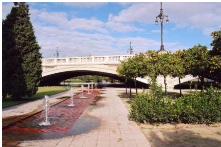
Figure 39: Passage sous les ponts qui relient les tronçons 24
