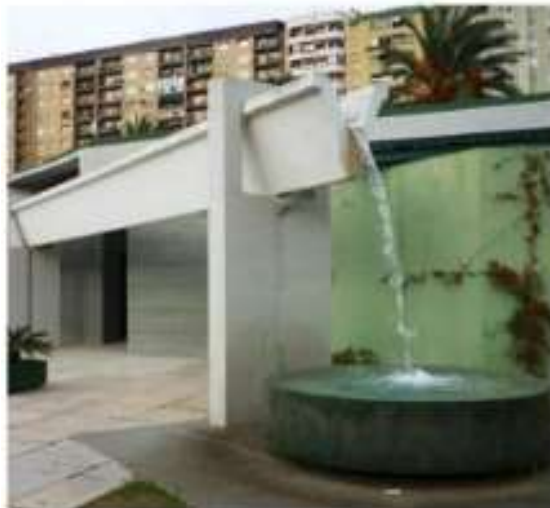
Figure 37: Fontaine d'eau sur le tronçon 1. Source: (Fabiano, 2013)
