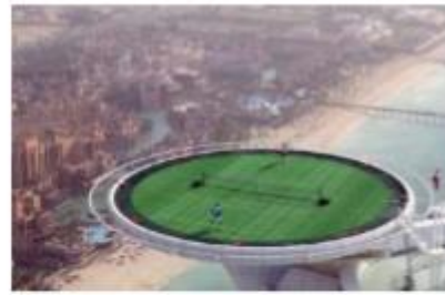
ouvrages d'arts (plaques circulaire)
