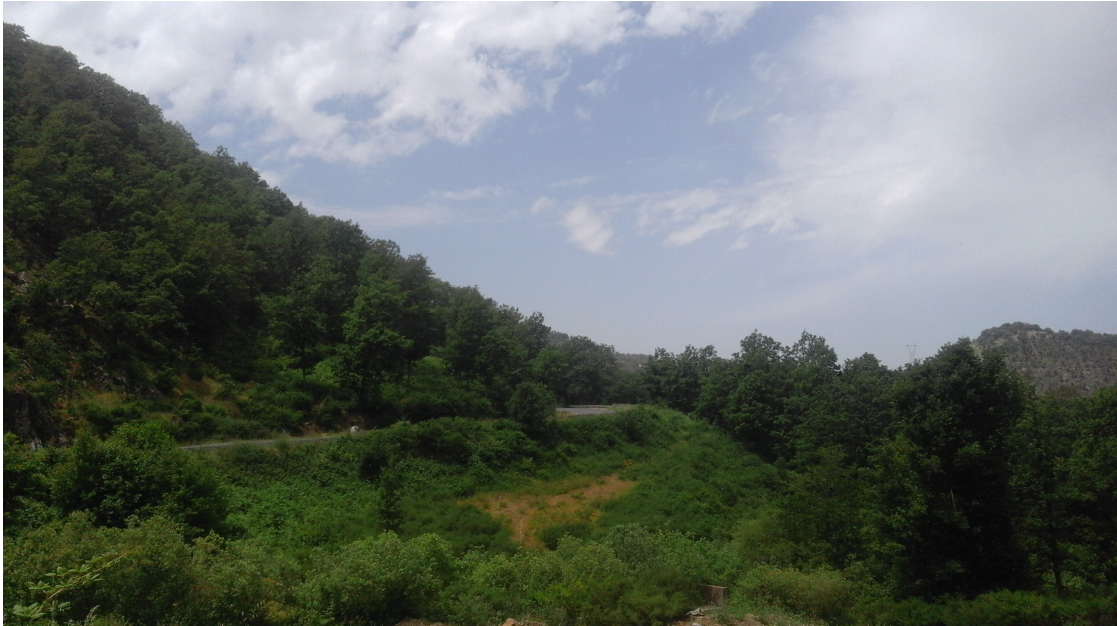
Figure n°14 : Vue générale sur la station d'Aghouled.
