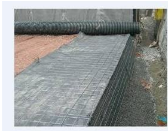
Figure I.13 : Cas avec bandes en géotextile
