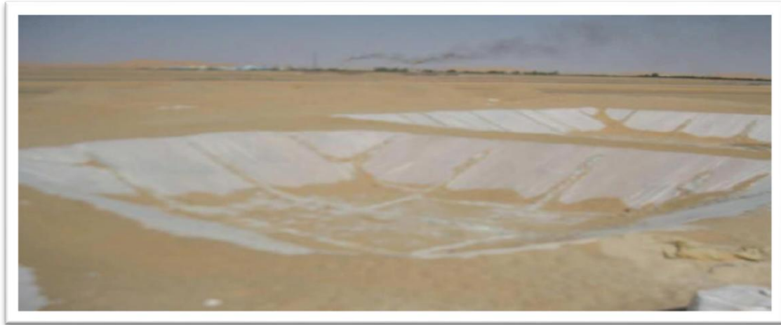
Figure II.10: Photo de Bourbiers étanche avant le forage. [Les fluides de forage à base d'huile Belahbib ; 2012]
