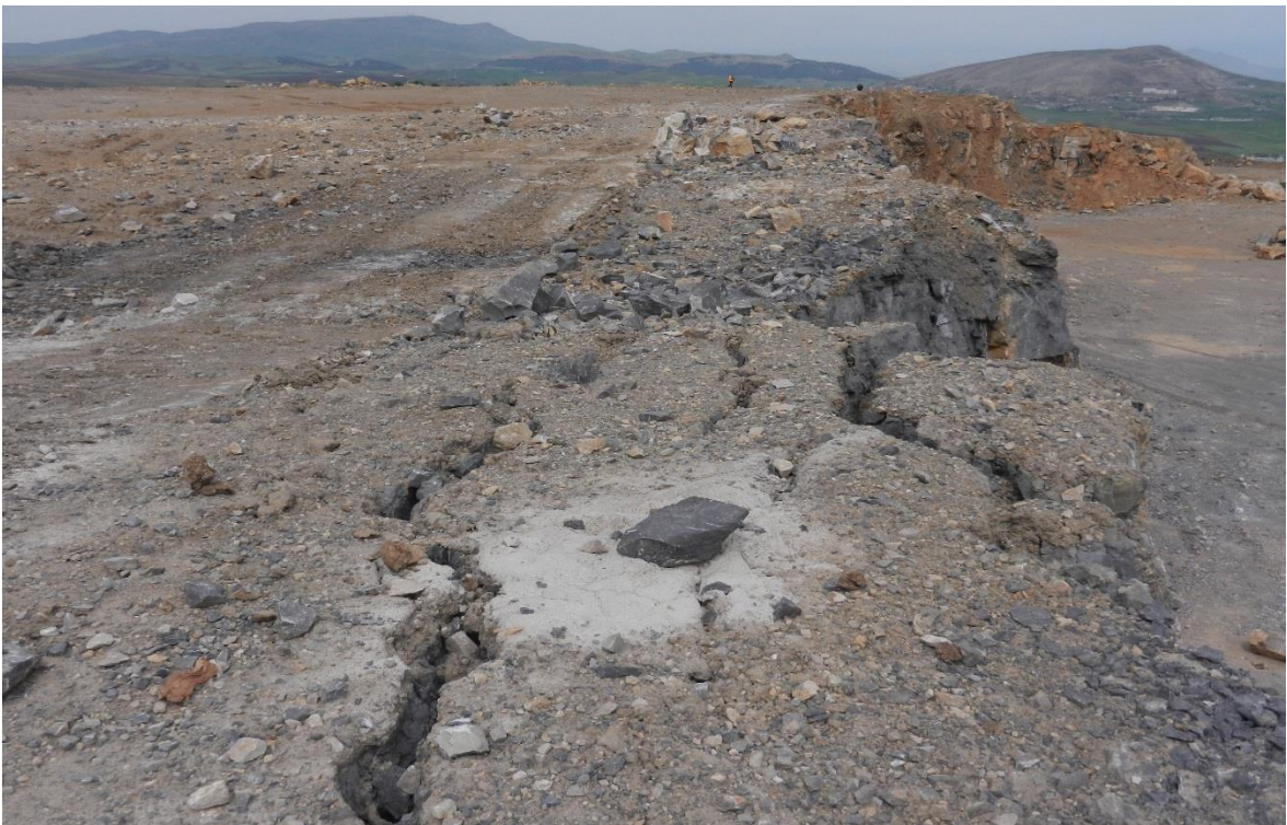
Annexe 14 : fissuration arrière dû après le tir (effet arrière)
