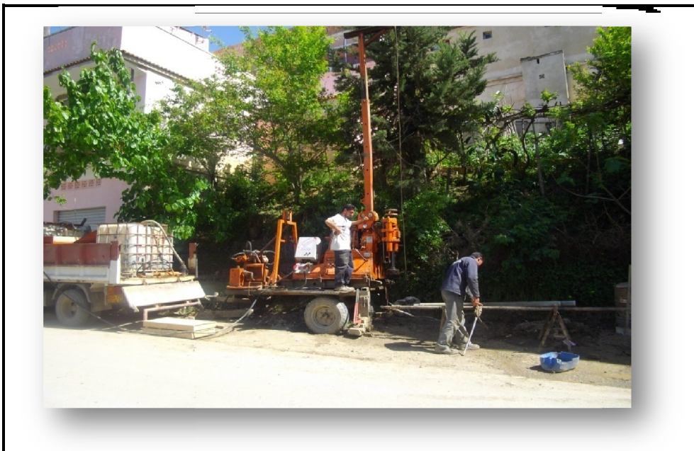
Photo.VI.10 : Photo de sondage carotté (PK 04+300).
