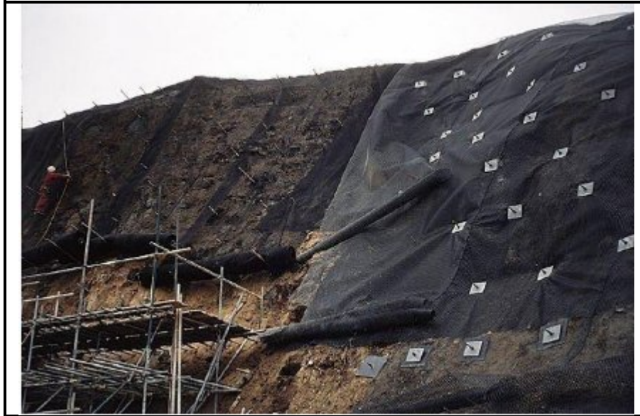
Photo .VI.3 : Un versant stabilisé par clouage.
