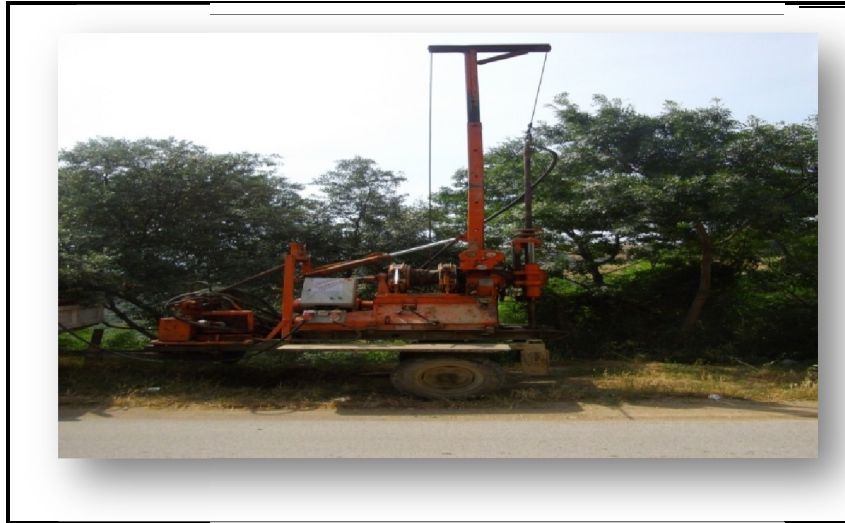
Photo.VI.12 : Photo de sondage carotté (PK 04+900).
