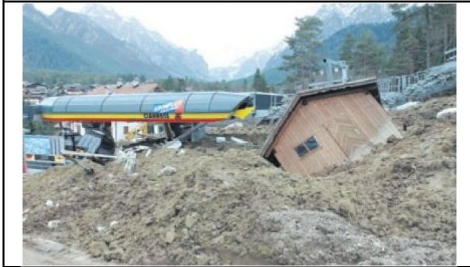
Photo .VI.2 : Les coulées boueuses.
