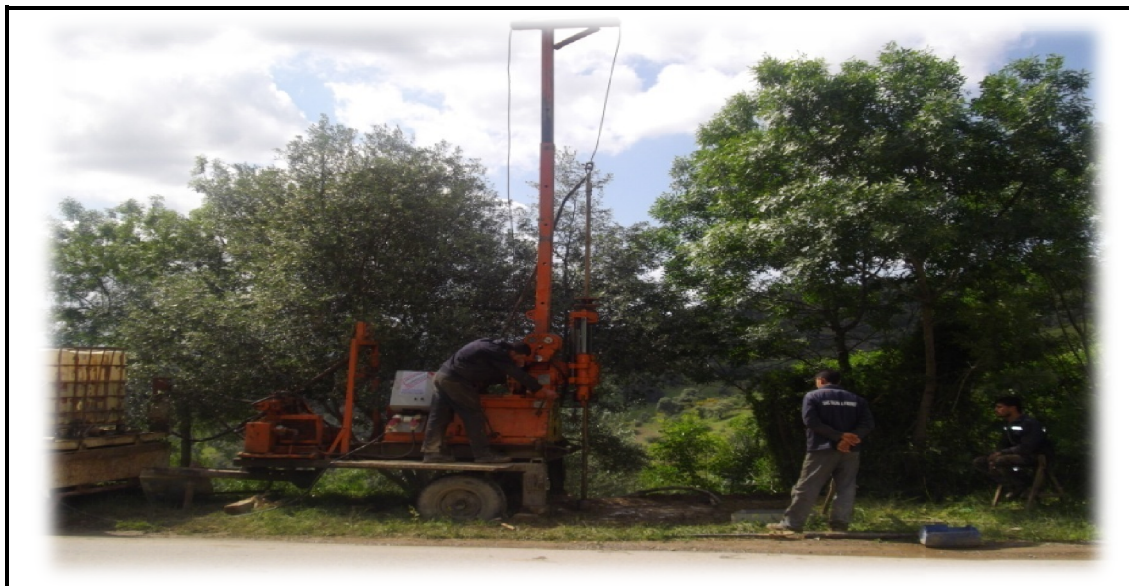
Photo.VI.8 : Photo de sondage carotté (PK 03+500).
