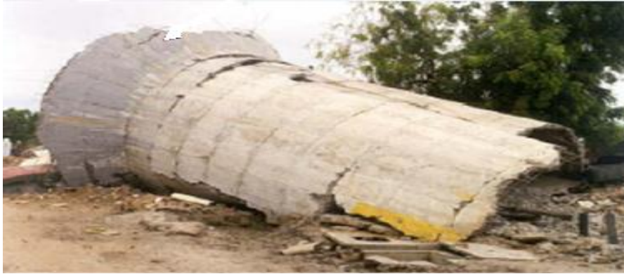
Fig. I. 11. Réservoir d'eau effondré de 265 kilolitres dans Bhuj 2001 Inde.
