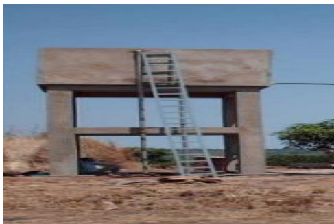
Fig. I. 4. Réservoir élevée rectangulaire.
