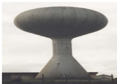
Fig. I. 8. Réservoir élevée sphéroïdale.
