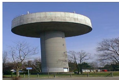
Fig. I. 5. Réservoir élevé circulaire.
