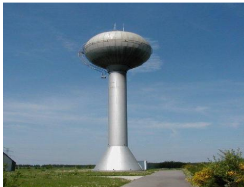
Fig. I. 6. Réservoir élevée sphérique.
