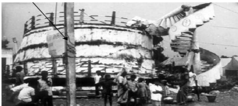
Fig. I. 14. Réservoir d'eau de Kautha après le tremblement de terre de Killari, 1993 Inde.
