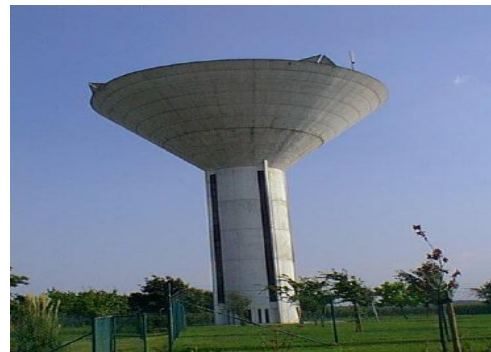
Fig. I. 7. Réservoir élevée a cuve fort encorbellement.
