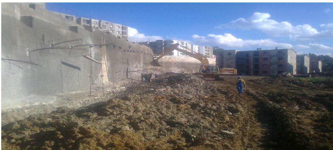
Figures IV.14: Mur à paroi tirantée (Boumerdes ,2012)
