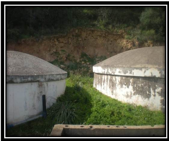
Photo 3 : Fissures dans les murs de chambre des vannes et manque d'étanchéité.
