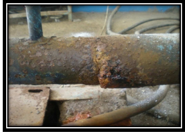
Photo 22 : Le forage V.S.A, clôture et éclairage inexistantes et les fuites repérée sur la conduite d'aspiration.
