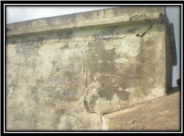
Photo 8 : chambre des vannes, mur fissuré, ferrailage dalle apparent, risque d'éboulements.
