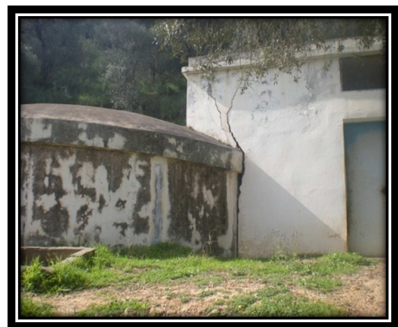
Photo 3 : Fissures dans les murs de chambre des vannes et manque d'étanchéité.
