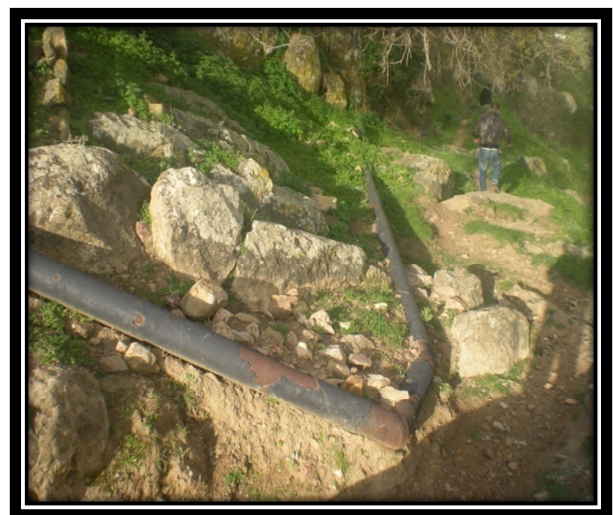
Photo 7 : Conduite d'adduction gravitaire Posée á même le sol, coude ne répondant pas aux normes et absence de la clôture.
