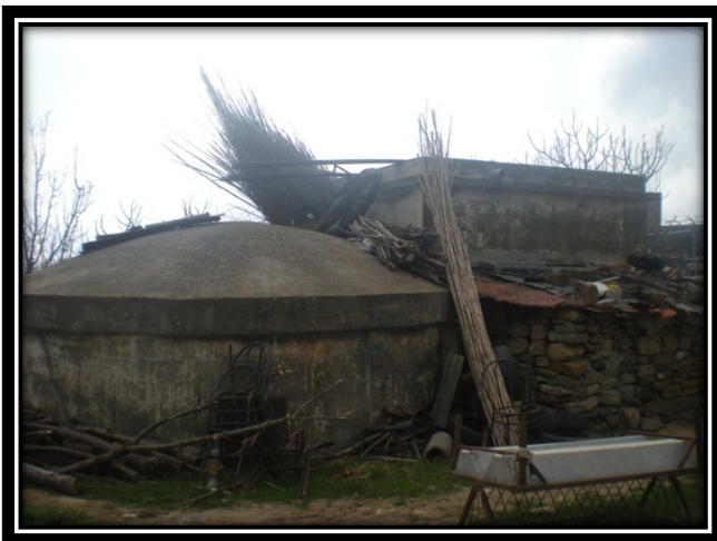
Photo 9 : réservoir Ait Chennit vue d'ensemble, le périmètre de protection du réservoir est encombré de toute sorte de débris, manque d'entretien.
