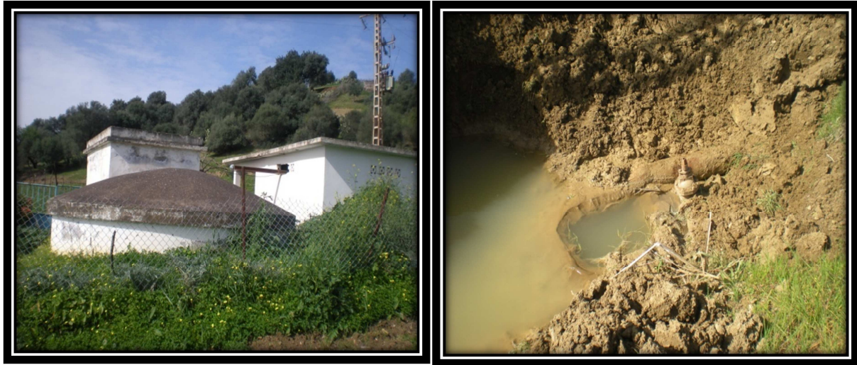
Photo 12: Clôture en Zimmermann dégradée, et vanne noyée dans l'eau.
