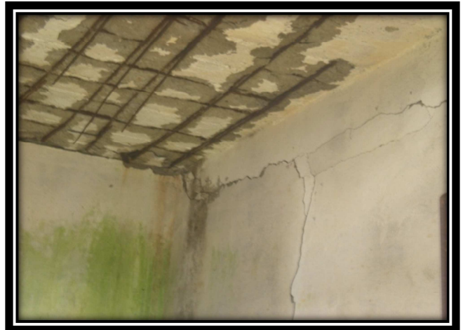
Photo 8 : chambre des vannes, mur fissuré, ferrailage dalle apparent, risque d'éboulements.
