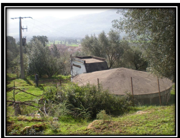
Photo 23: Vue l'ensemble du réservoir V.S.A, clôture dégradée, et manque d'entretien.
