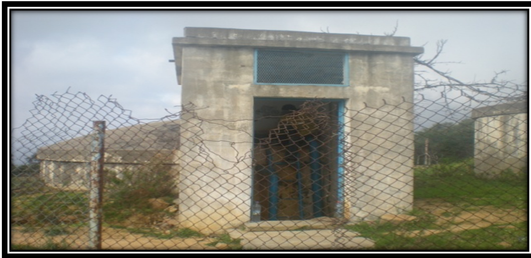
Photo 6 : Le réservoir Boubzi, clôture en Zimmerman détériorée et absence d'entretien.
