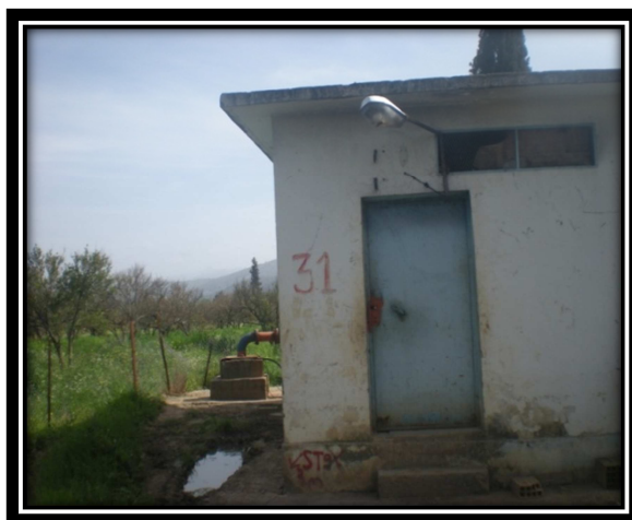
Photo 1: Abri de forage en service
