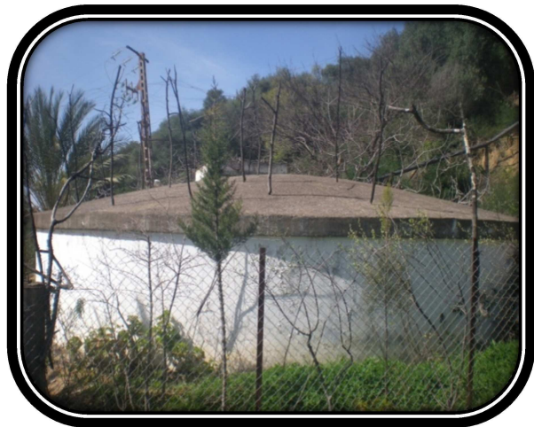
Photo 16 : vue d'ensemble du réservoir, encombrement par la broussaille, clôture en Zimmerman dégradée.
