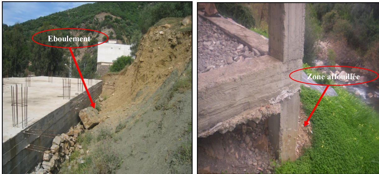
Figure 25: Dégradation des habitations à cause des instabilités
