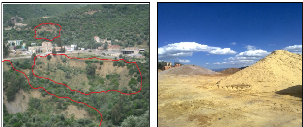
Figure 37: Etat des talus chargés en remblais
