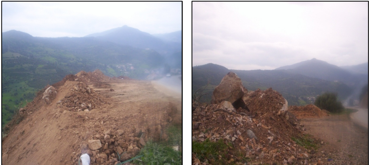
Figure 37: Etat des talus chargés en remblais
