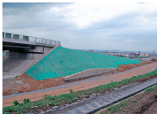
Figure (I-30) : Mise en place de la géogrille [21]
