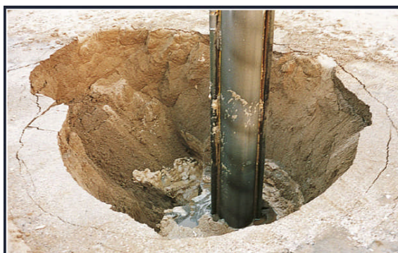
Figure (I-40) : Cône d'affaissement
