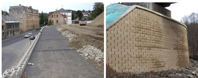
Figure (I-29) : Murs en terre renforcée par géosynthétique [21]
