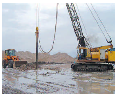
Figure (I-46) : Réalisation des colonnes ballastée
