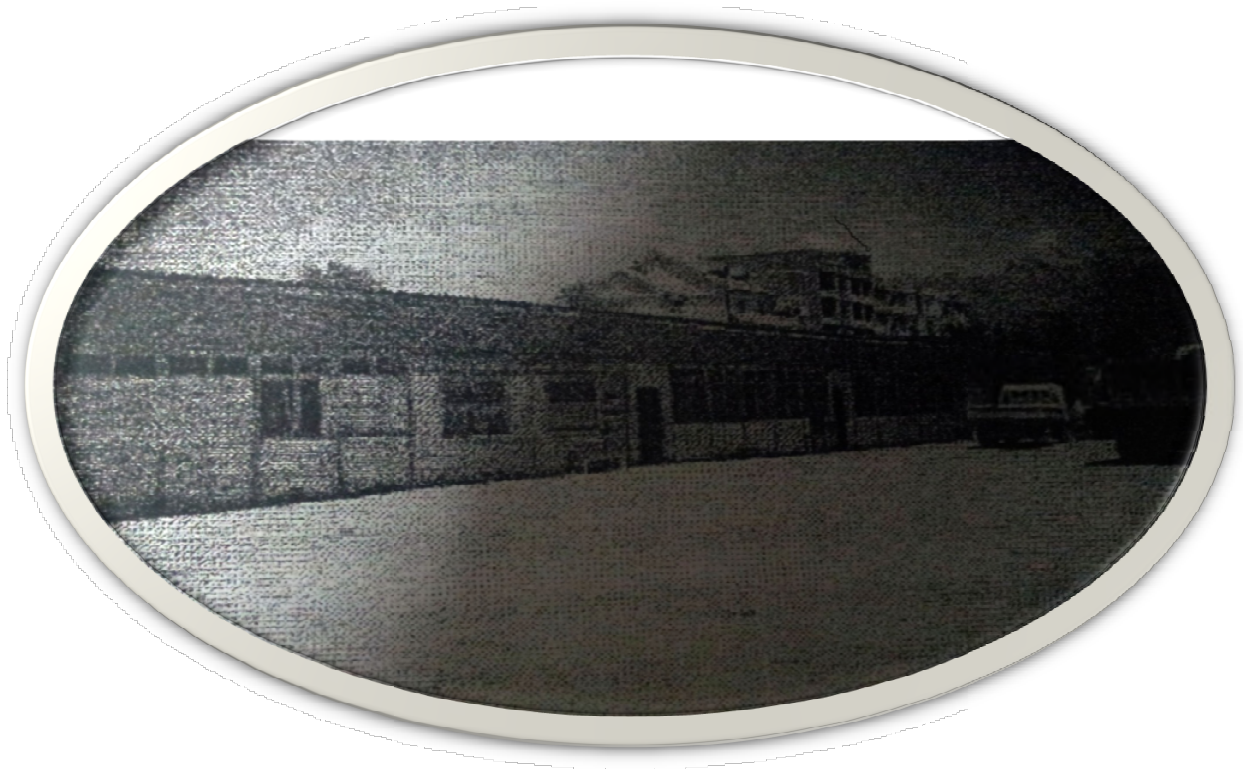
Figure 6 : Siège du service de nettoyage de la commune de Bejaia.
