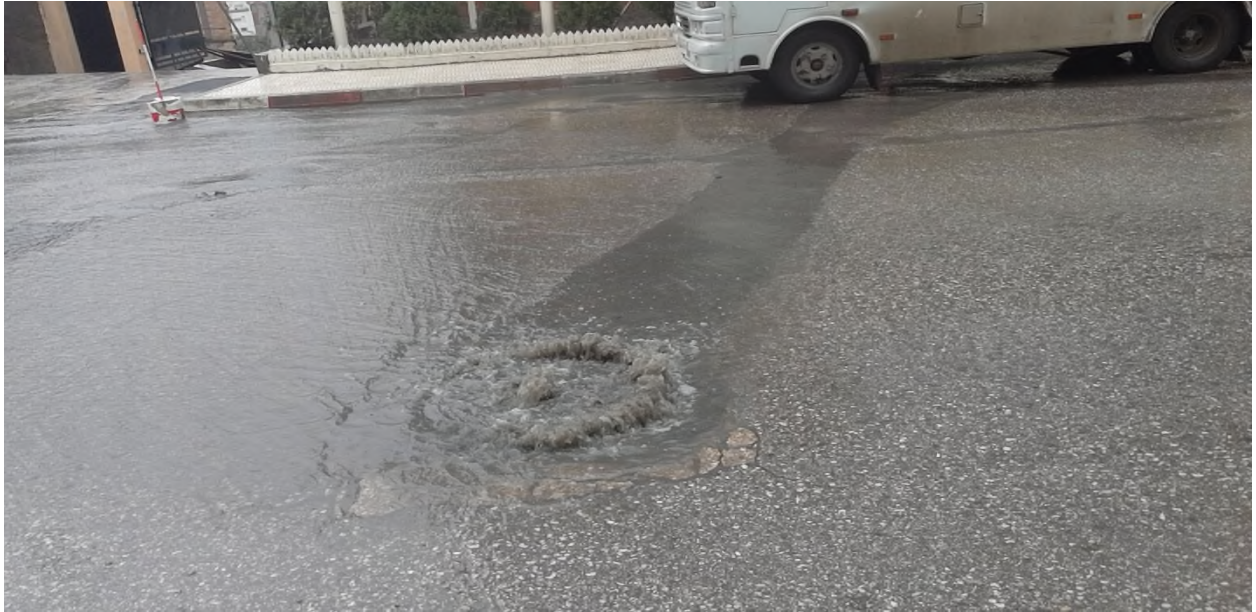
Figure (III-12) : Débordement d'un regard.
