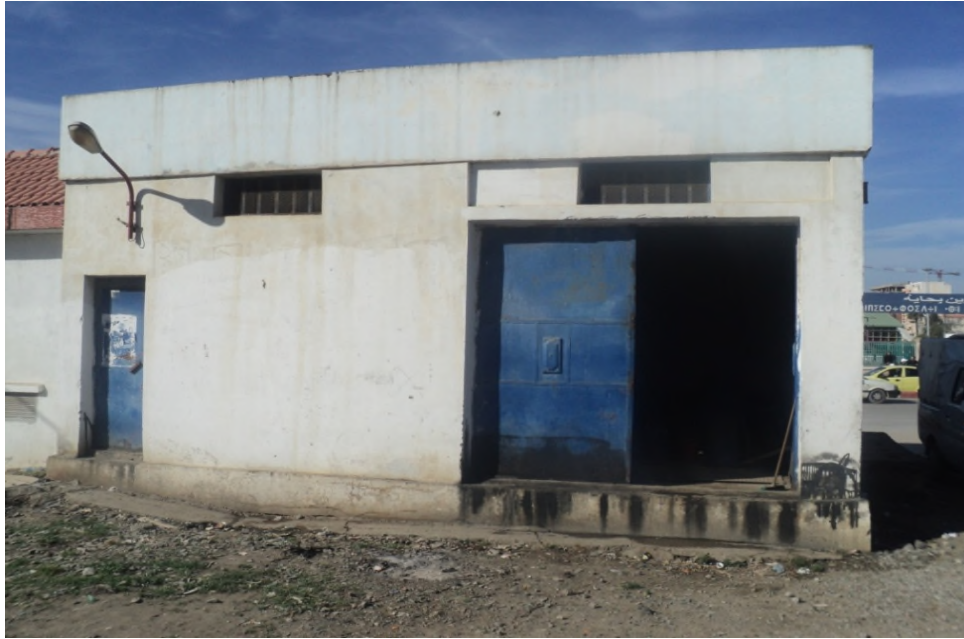
Figure (IV-1) : station de relèvement quatre chemins
