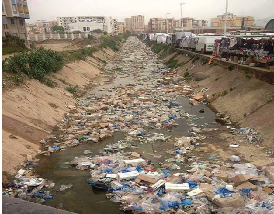
Figure (III-18) : État de l'Oued Seghir à proximité du marché.
