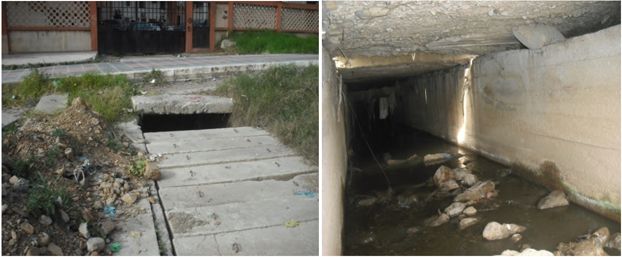
Figure (I-5) : Oued canalisé en galerie fermée (Rue de la liberté)
