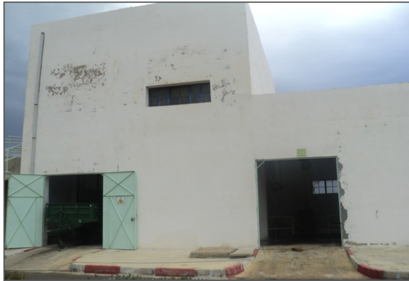
Figure (IV-6) : station de refoulement STEP Sidi Ali L'Abhar.
