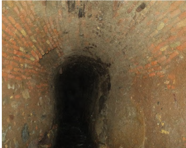
Figure (II-7) : Collecteur en brique sous forme ovoïdale.
