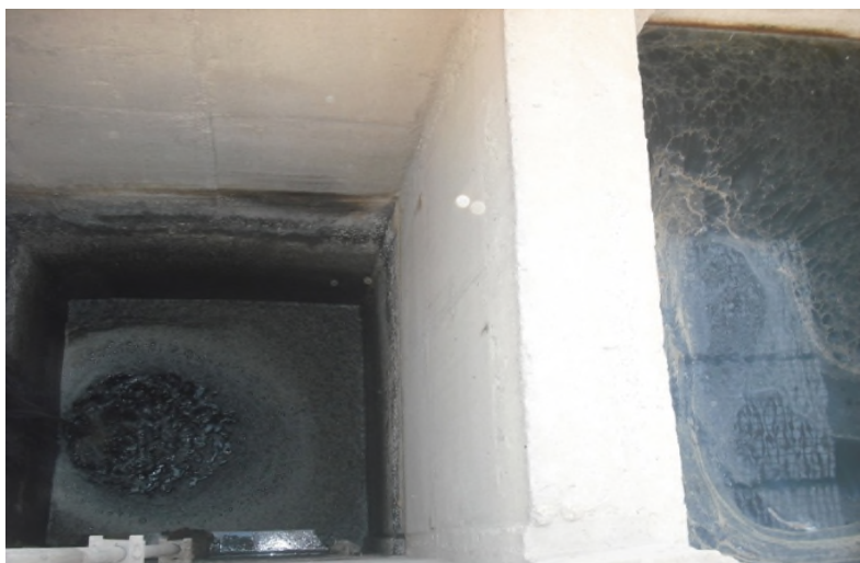
Figure (IV-8) : Déversoir d'orages situé en amont de STEP Sidi Ali L'Abhar.
