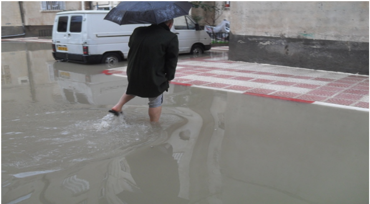
Figure (III-13) : Inondation de voirie à Sidi Ali L'Abhar (Problèmes d'avaloirs).
