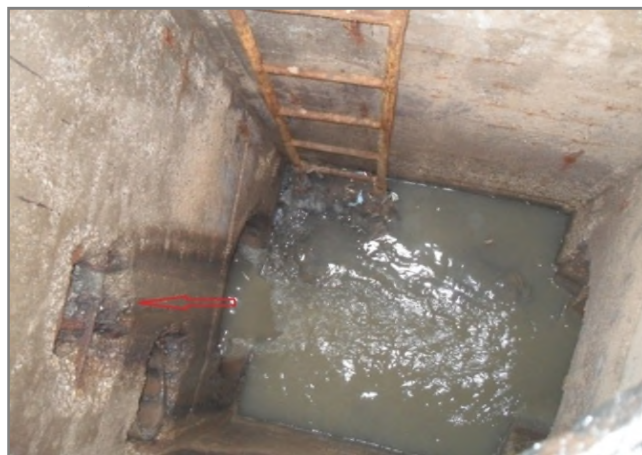
Figure (II-19) : Trop plein du réseau.
