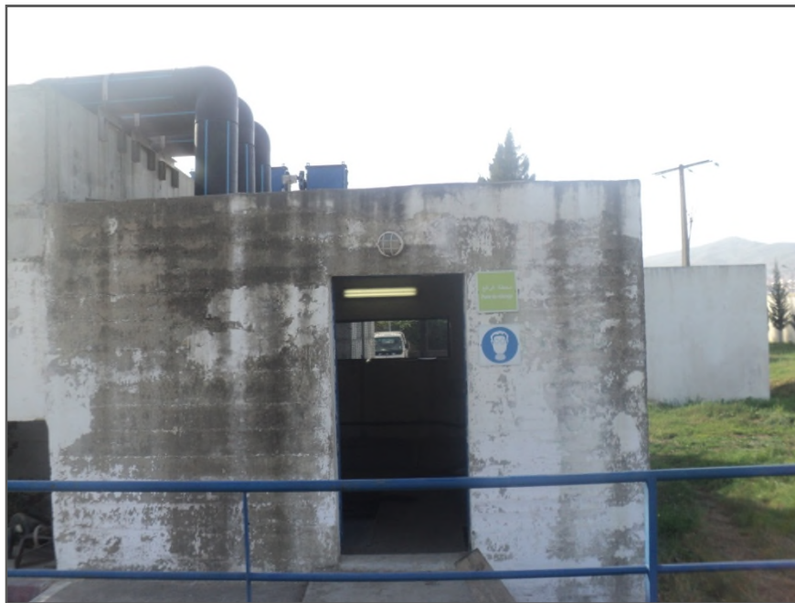
Figure (IV-5) : station de refoulement Centre-ville.
