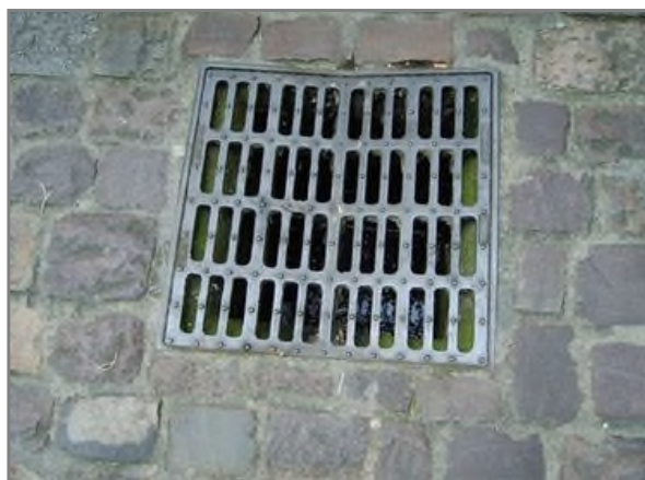
Figure (II-9) : Bouche d'égout à grille.
