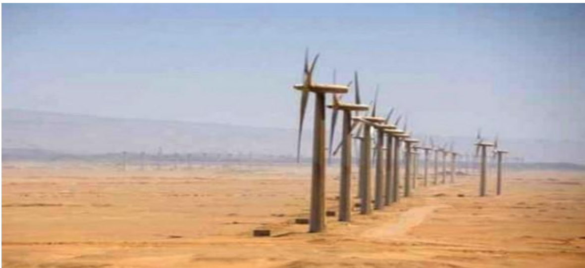
Figure (I.2) la ferme éolienne d'Adrar
