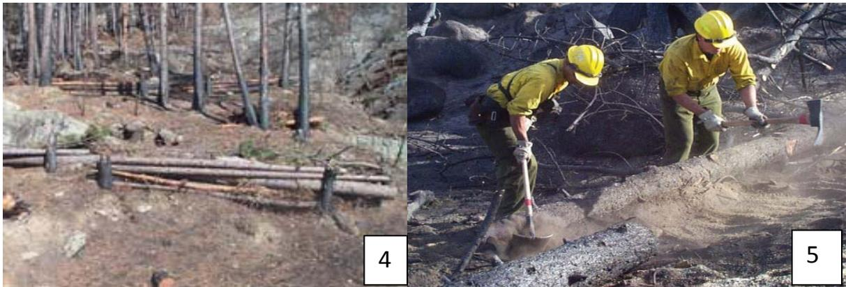
**PHOTO N° 4 et 5:** le fascinage des versants et installation des troncs d'arbres brûlés pour le contrôle d'érosion après feu. (Photo 5 de Robichaud, 2005).
