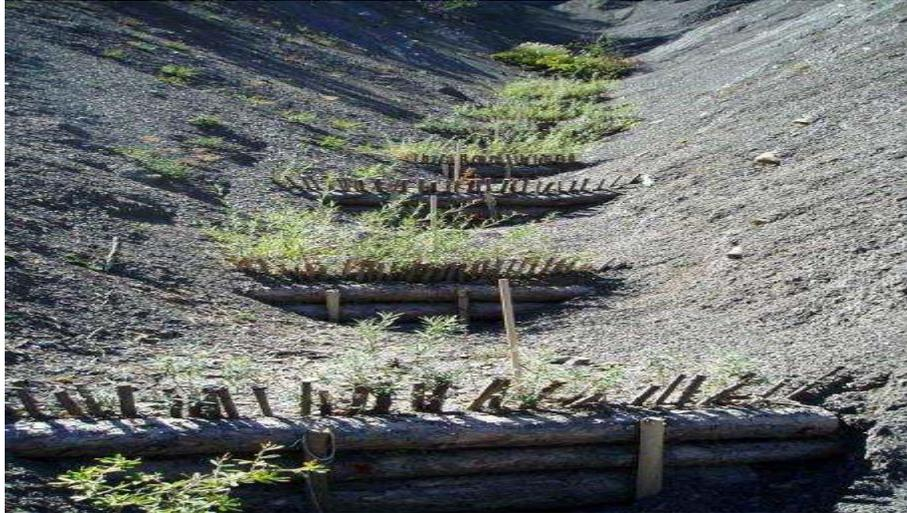
**PHOTO N° 1 :** Barrières végétales installées dans le lit d'une ravine (Photo Burylo, 2011).
