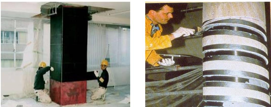
Figure I.13. Exemple de renforcement de colonnes par des matériaux composites [20]
