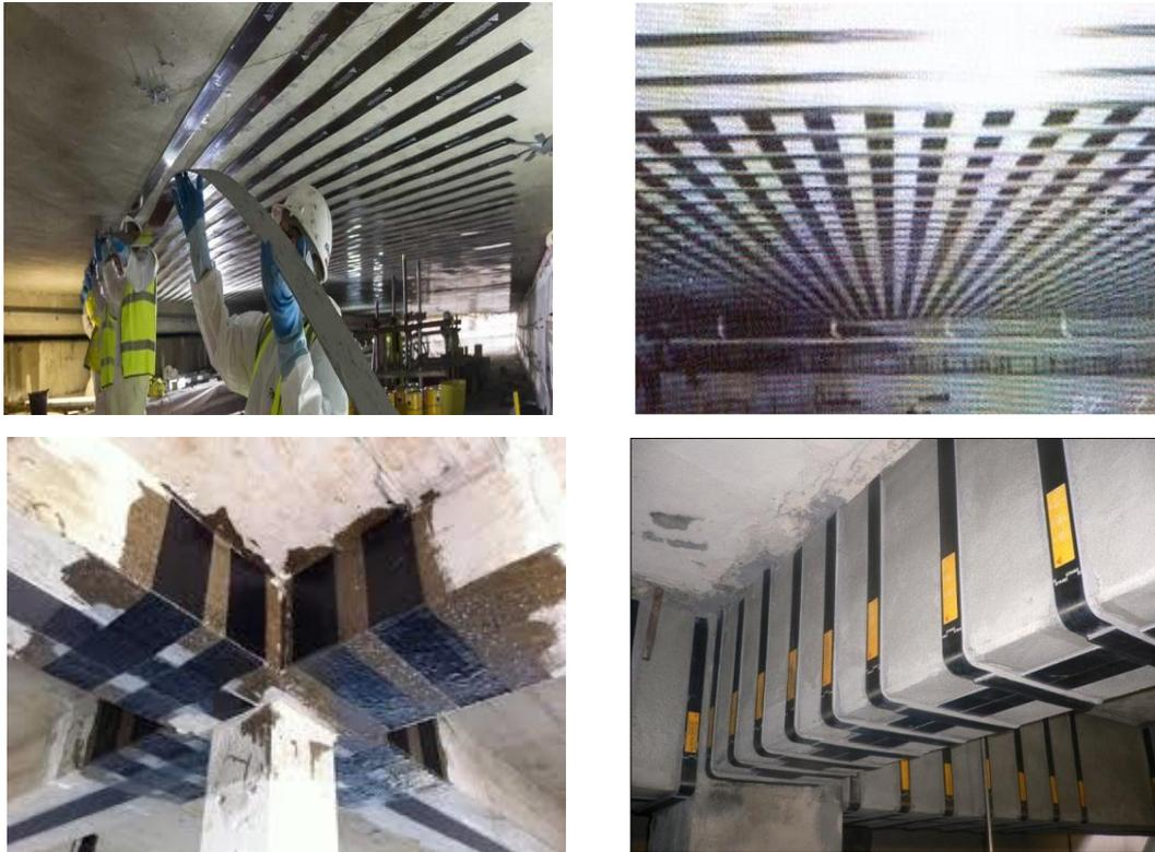
Figure I.12. Renforcement des dalles et poutres par des matériaux composites. [21]
