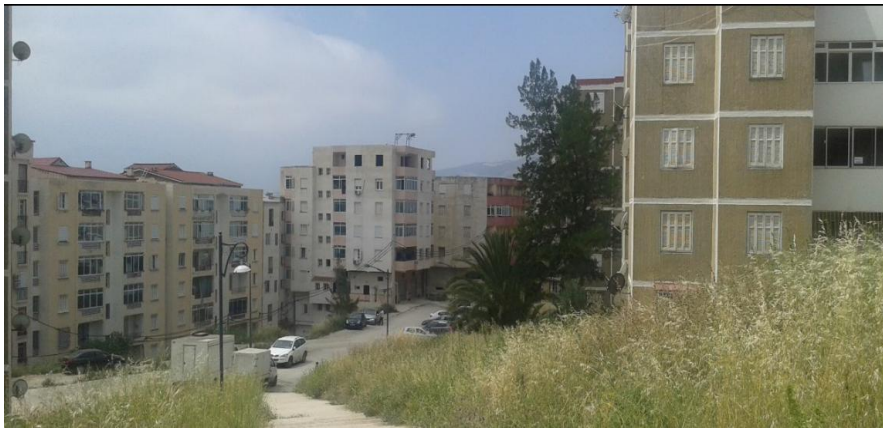
Photo 08 : Hétérogénéité des façades
