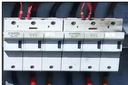
Figure II.14 : Disjoncteurs utilisés dans la station
