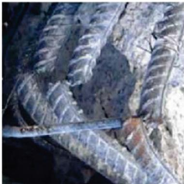
(c) Rupture des armatures
