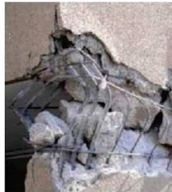
(d) Ecrasement du béton et flambement des armatures
