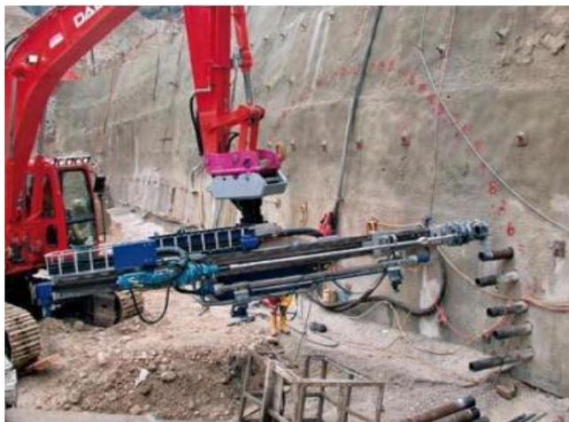
Figure II.7 : Matériels utilisé pour réalisation des tubes AT-127.
