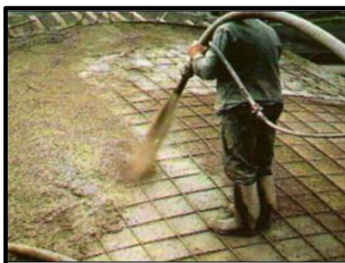
**Figure I.9 :** Béton projeté.
