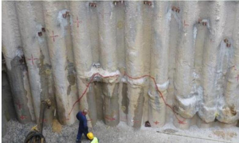
**Figure II.9** : traçage de merlon.
