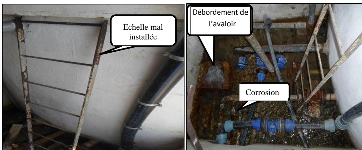
Figure II-5 : Etat du réservoir R1 d'EL-AINSER
