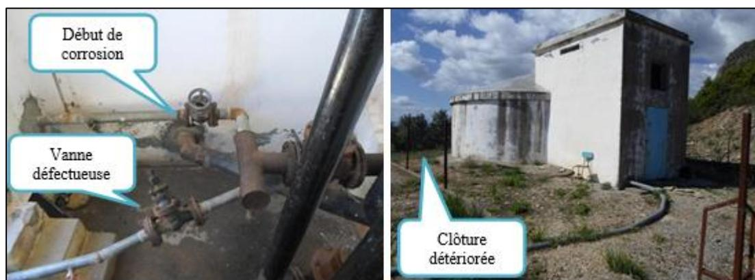
Figure II-7 : Etat du réservoir R3 N'TABLATE
