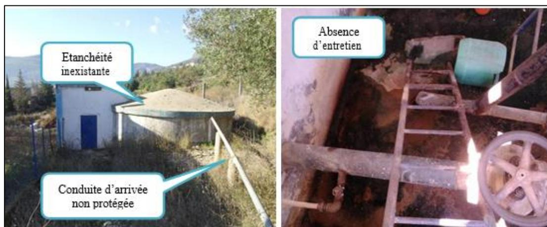
*Figure II-8 : Etat du réservoir R4 d'EL-MERJ*
