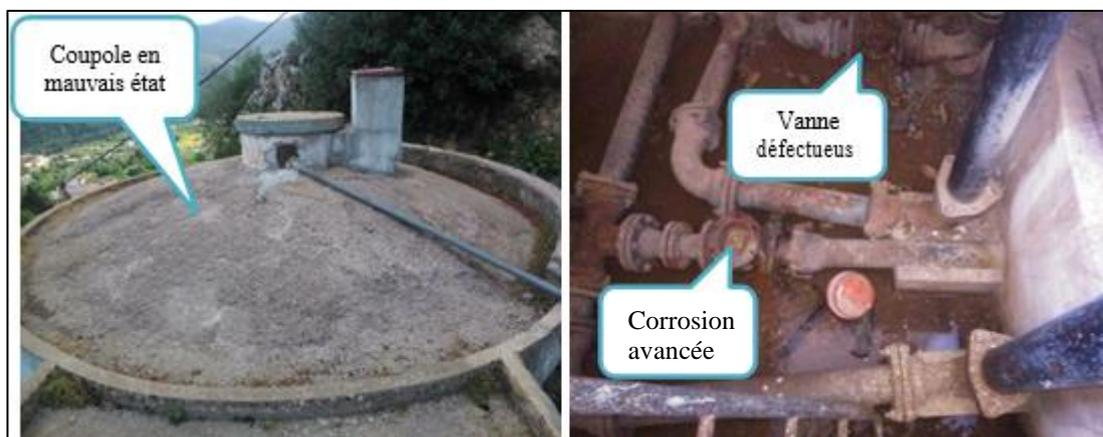
Figure II-6 : Etat du réservoir R2 d'IBOURDJIOUENE
