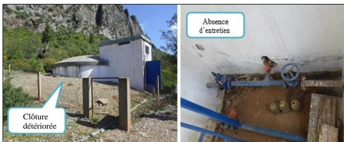
*Figure II-9 : Etat du réservoir R5 de TIMANITHINE*
