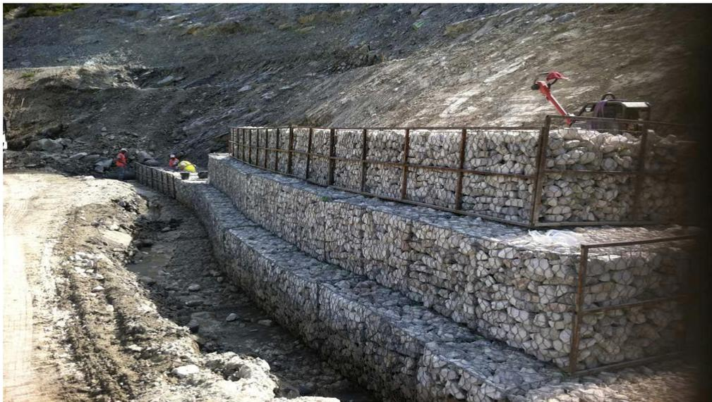
**Figure III.3: Protection d'un cours d'eau par du gabion compartimenté (UPGE).**
