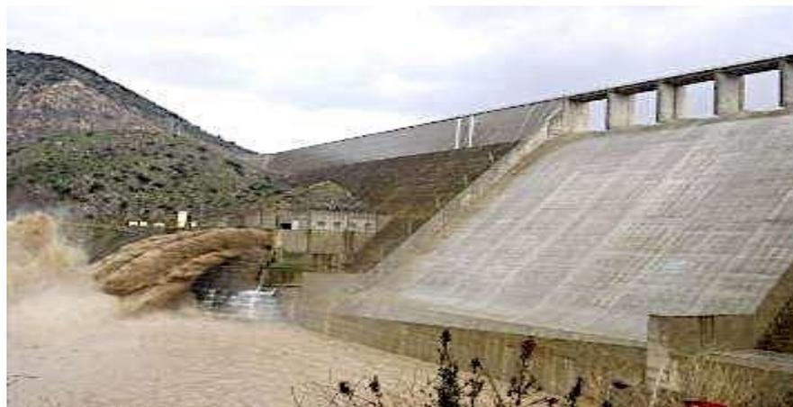
**Figure III.4: Suspension soutirée par les pertuis de vidange du barrage de Beni Haroun émanant d'un courant de densité (Photo. ANBT 2014).**
