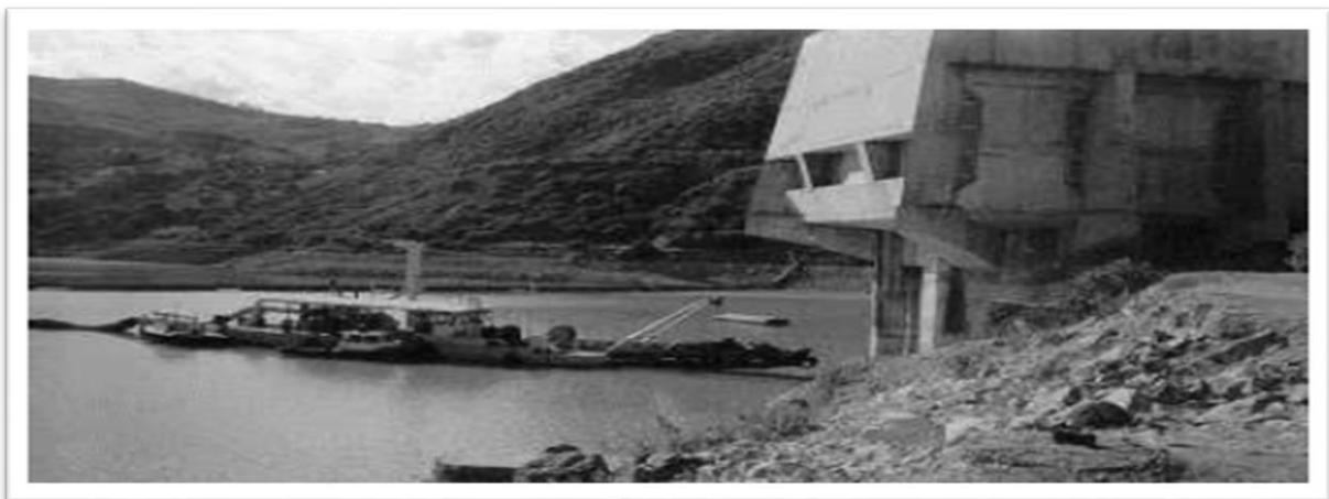
**Figure II.1.2 : Opération de dragage du barrage des Zardezas.**
