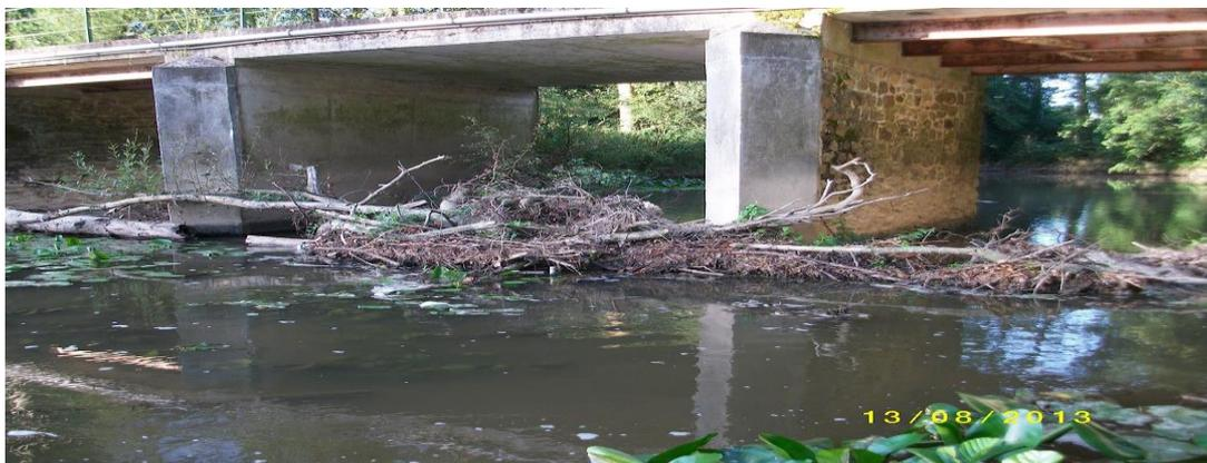
**Figure III.2: Embâcles dans le pont des ifs à Montsûrs en France.**
