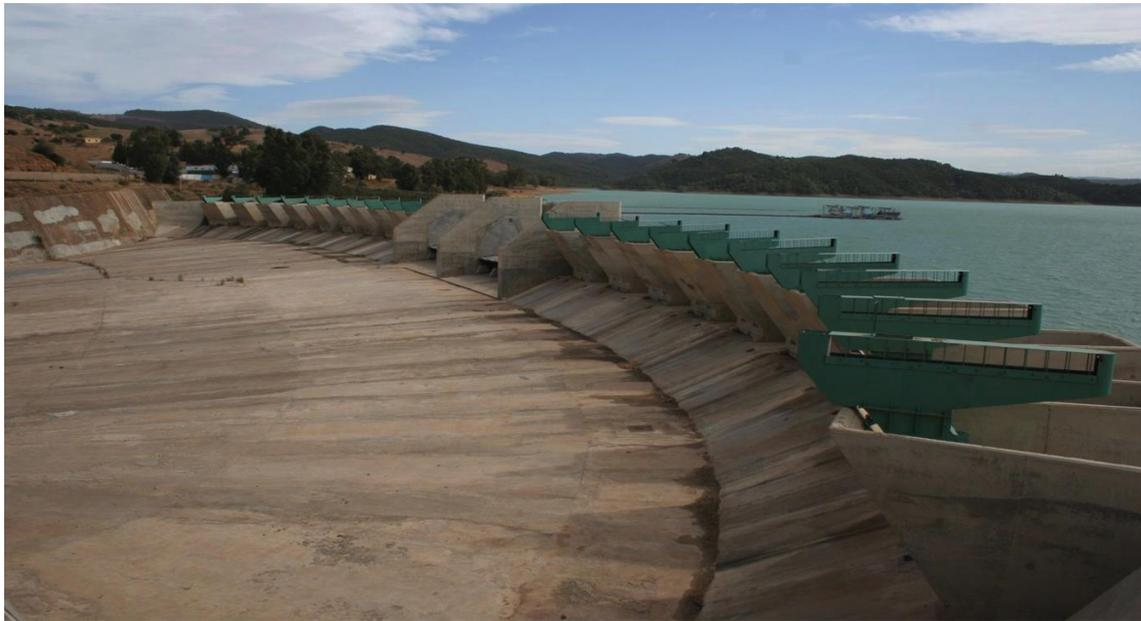
**Figure III.5 : Surélévation du barrage Ghrib par des hausses fusibles [Remini.B, 2017].**
