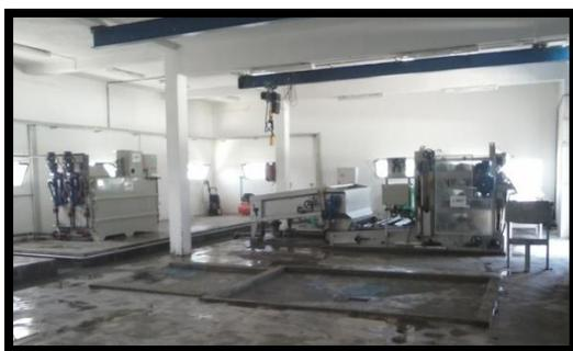
**Figure I.13 :** Bloc de déshydratation des boues
