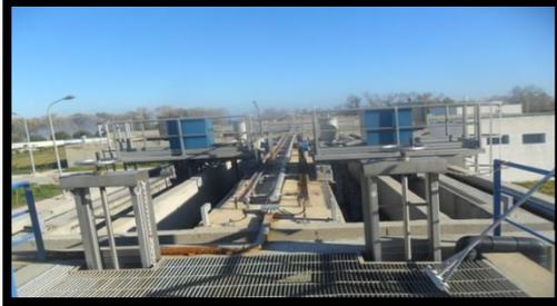
Figure I.7 : Pont déshuilage-dessablage.
